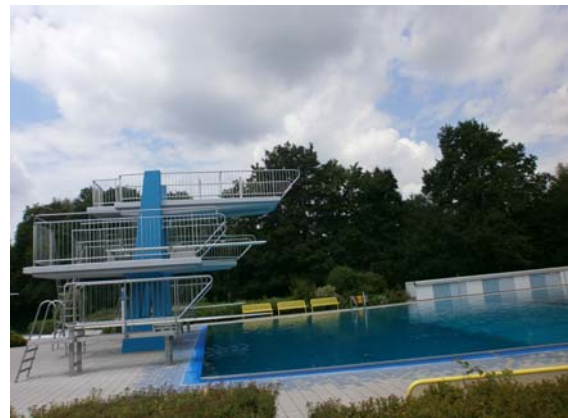
Abb. Sprunganlage Freibad Aquamarin Bobingen
