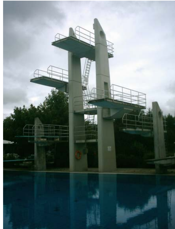
Abb. Sprunganlage Freibad Gemering
