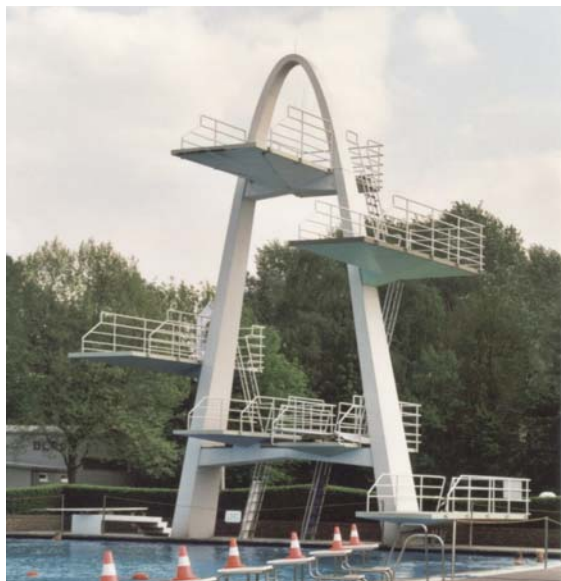
Abb. 10-m-Sprungturm des ehemaligen Freizeitbades Delfina, Delmenhorst
